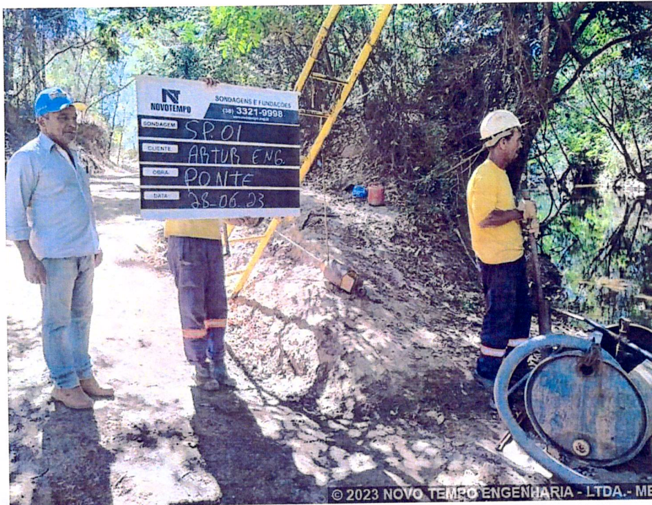
Foto 1 – EXECUÇÃO SONDAGEM À PERCUSSÃO SP 01 - BUENÓPOLIS/MG
