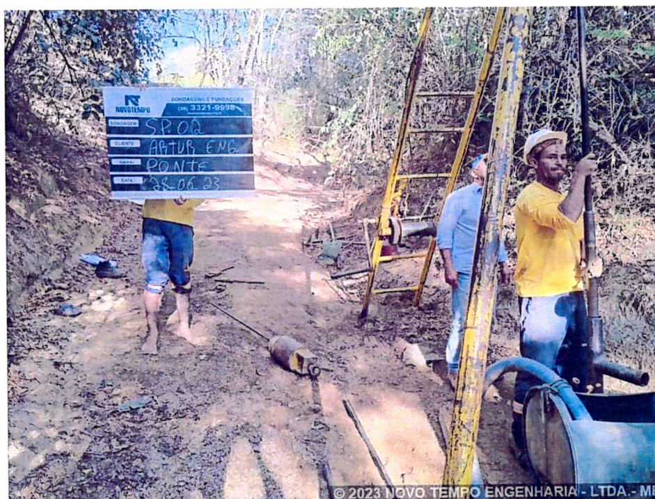
Foto 2 – EXECUÇÃO SONDAGEM À PERCUSSÃO SP 02 - BUENÓPOLIS/MG
