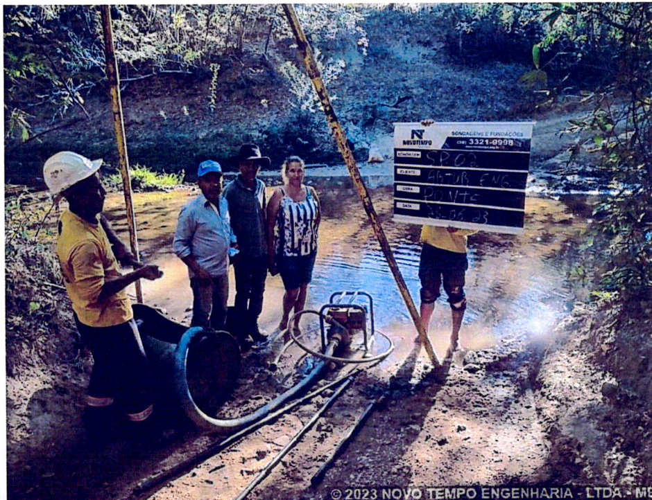
Foto 1 – EXECUÇÃO SONDAGEM À PERCUSSÃO SP 02 - BUENÓPOLIS/MG
