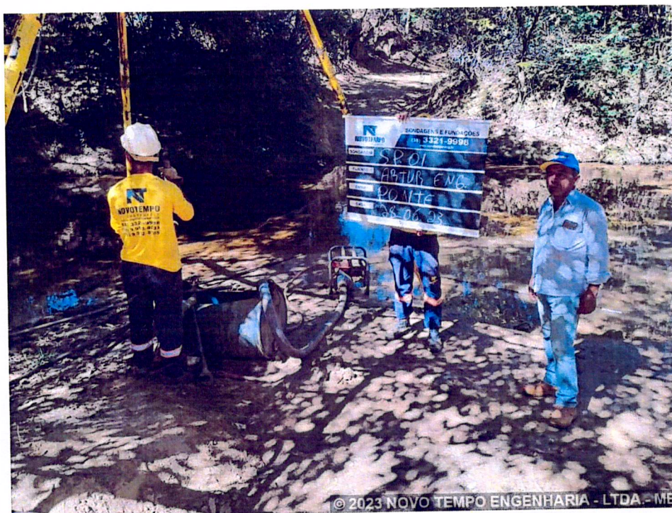
Foto 2 – EXECUÇÃO SONDAGEM À PERCUSSÃO SP 01 - BUENÓPOLIS/MG
