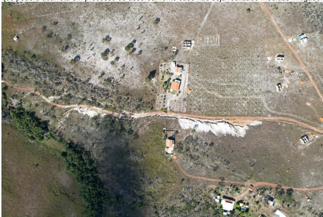
Figura 01: Vista aérea da área de interesse de execução do projeto de Rip Rap.
